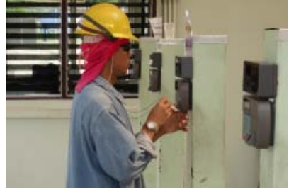
ระบบ Access Control with Finger Scan
