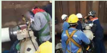
รูปที่ 4 ทำการเชื่อมแนว Longitudinal และทำ MT.
