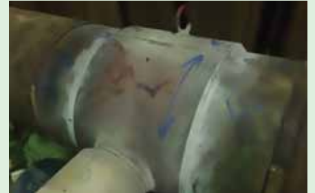
รูปที่ 6 การเชื่อม Split-tee ที่เสร็จสมบูรณ์
