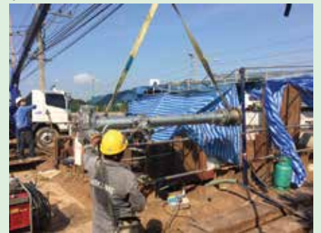
รูปที่ 7 การนำเครื่องเจาะลงหลุม
