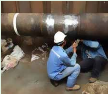
รูปที่ 1 การติดตั้ง Clamp ground
