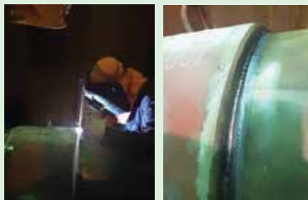
รูปที่ 5 ทำการเชื่อมแนว Circumference
