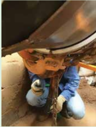
รูปที่ 3 ทำ Fit up โดยใช้ก๊ามะลอช่วยในการรัดแน่น
