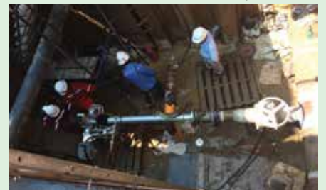
รูปที่ 8 การทำ Pressure test ที่เครื่องเจาะ
