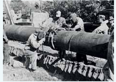
รูปที่ 3 การประกอบท่อด้วยการเชื่อม
