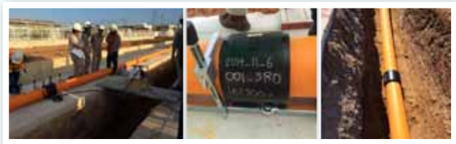
รูปที่ 4 Welding-Joint Marking, Lower-in of Pipeline and Backfill
