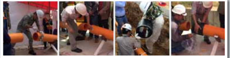
รูปที่ 2 Preparation of the Welding Surface
