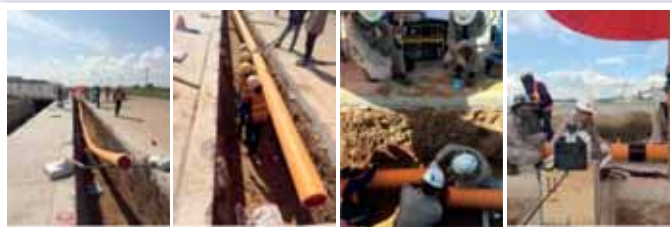
รูปที่ 1 การก่อสร้างท่อจัดจำหน่ายก๊าซธรรมชาติด้วยท่อ HDPE (High Density Polyethylene)
