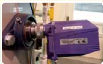
รูปที่ 3 Flame Detector ชนิด Flame rod
