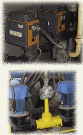
ภาพแสดงตัวอย่างอุปกรณ์ Safety Shutoff Valve แบบ Double Block and Bleed
