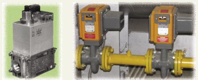
ภาพแสดงตัวอย่างอุปกรณ์ Safety Shutoff Valve แบบ Double Block
