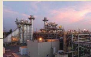
กัลฟ โดเจนเนอเรชั่น (โรงไฟฟ้าแก่งคอย)
