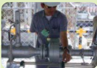
7-8 ตรวจสอบความปลอดภัยของระบบท่อก่อนการจ่ายก๊าซเข้าระบบ M/R Station ใหม่ ให้กับ บริษัท โคห์เลอร์ (ประเทศไทย) จำกัด
