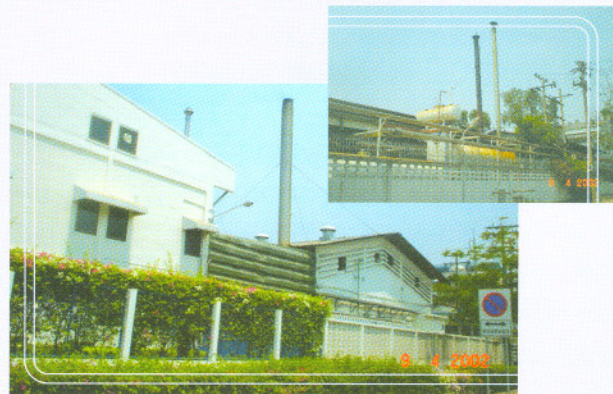
รูปที่ 1 แสดงลักษณะของโรงงานที่ตั้งในเขตการนิคมบางชัน
