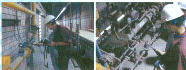
ทีมงาน Inplant Service ส่วนบริการลูกค้าก๊าซ ปตท. ตรวจสอบ และให้คำแนะนำเรื่องความปลอดภัยของระบบท่อส่งก๊าซภายในโรงงานอุตสาหกรรม
