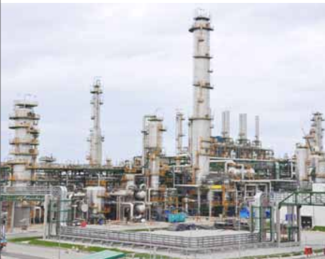
โครงการก่อสร้างโรงผลิตเม็ดพลาสติก LLDPE
