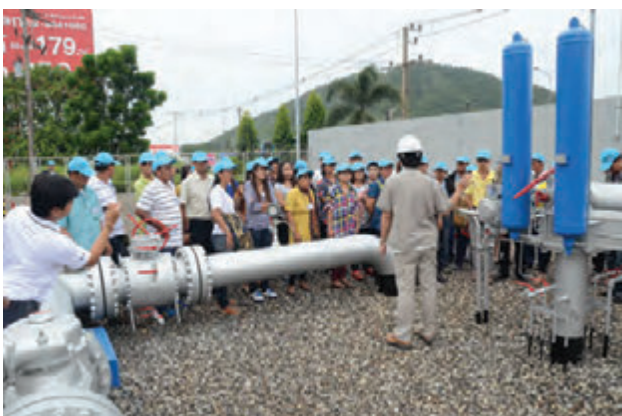
ชมสถานีควบคุมความดันก๊าซฯ
