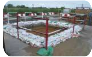
กันพื้นที่บ่อรับ-ส่ง ด้วยถุงทราย / กระสอบทรายกันโดยรอบ
