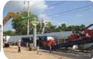
การติดตั้งกำแพงกันเสียง
