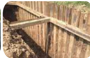
การติดตั้ง Sheet pile ป้องกันการพังทลายของดิน
